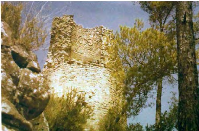
"Cap de la Torre". Terme Balsareny- Castellnou
